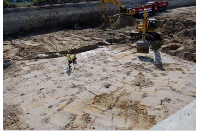
Wykop uszczelniony przez przesłonę jet grouting pomiędzy ścianami szczelinowymi, fot. Krzysztof Skowroński
