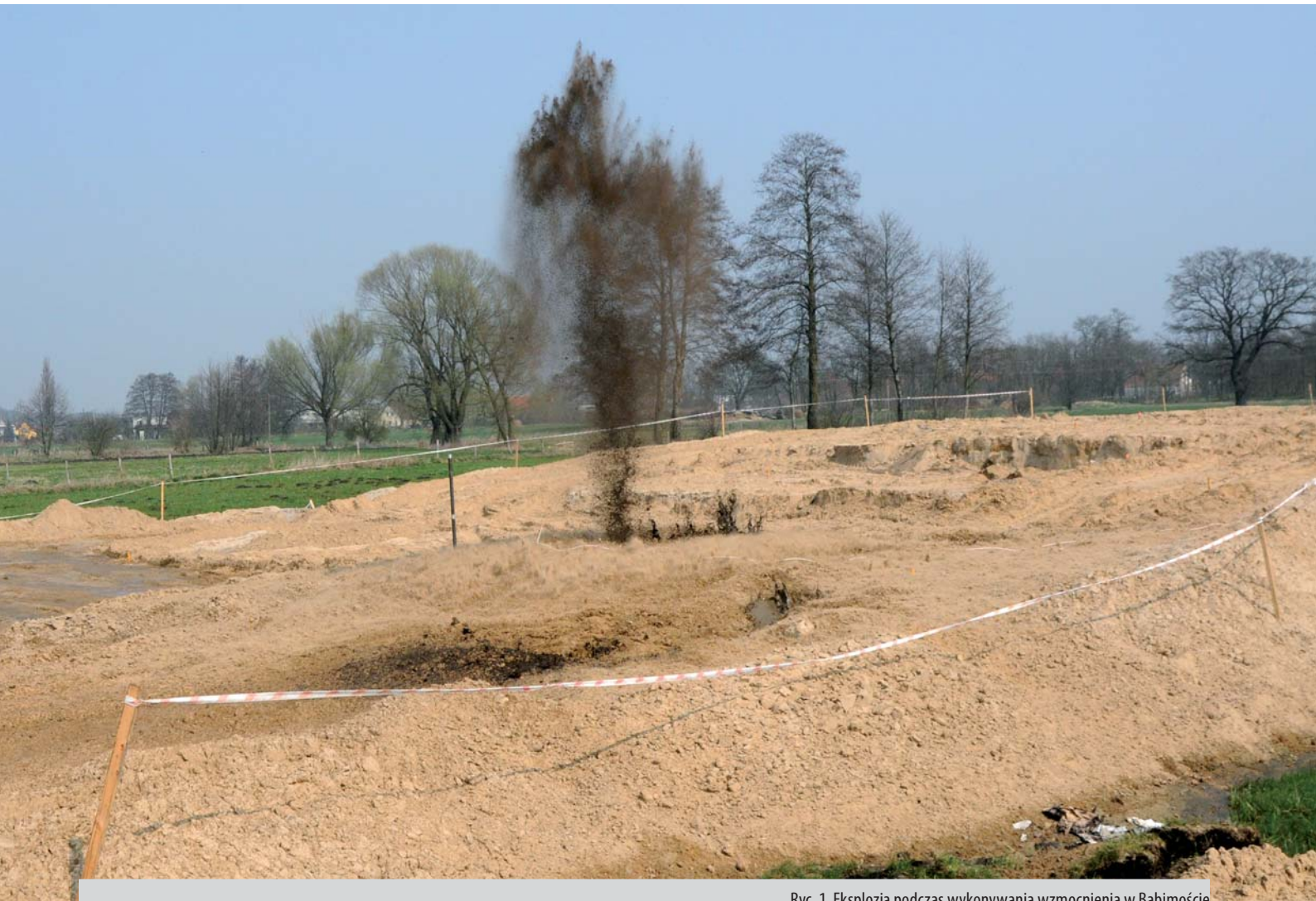
Ryc. 1. Eksplozja podczas wykonywania wzmocnienia w Babimostcie
