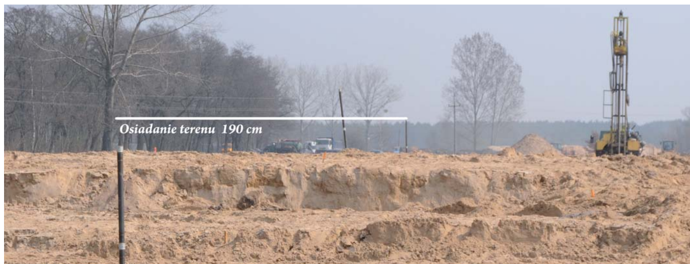
Ryc. 3. Osiadanie gruntu uzyskane natychmiast po seriach strzałowych
