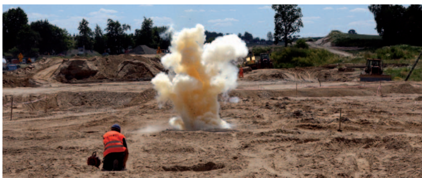
Technologia mikrowybuchów jest widowiskowa i bezpieczna. Stosowano ją już do wzmacniania podłoża pod drogi.
